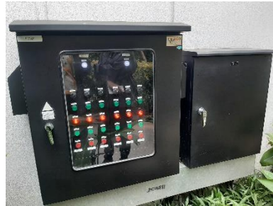
ตู้ควบคุมการเปิด-ปิดไฟทางเดิน
