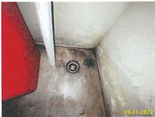
ภาพที่ 2.2-62 ตะแกรงครอบรูวางระบายน้ำ
