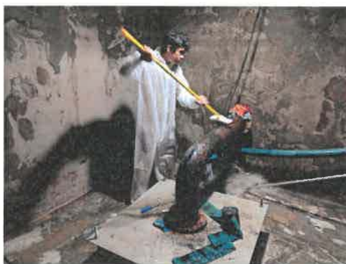
ภาพที่ 2.2-17 ล้างทำความสะอาดถังสำรองน้ำ
