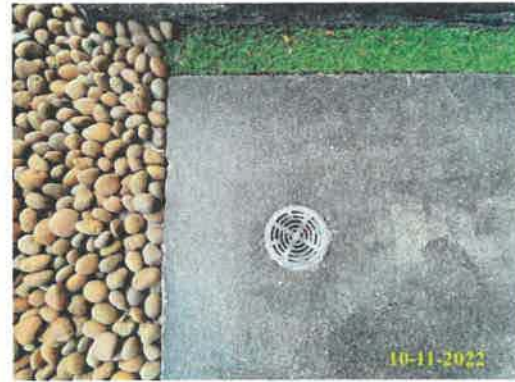
ภาพที่ 2.2-62 ตะแกรงครอบรูวางระบายน้ำ
