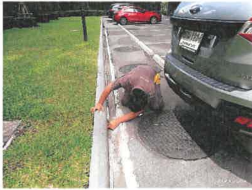
ภาพที่ 2.2-24 ทำความสะอาดรางระบายน้ำ
