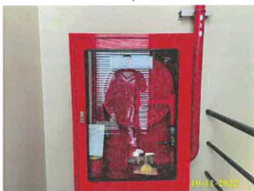
ตู้เก็บสารฉีดยาน้ำดับเพลิงและอุปกรณ์
