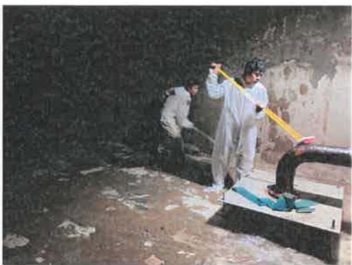
ภาพที่ 2.2-17 ล้างทำความสะอาดถังสำรองน้ำ
