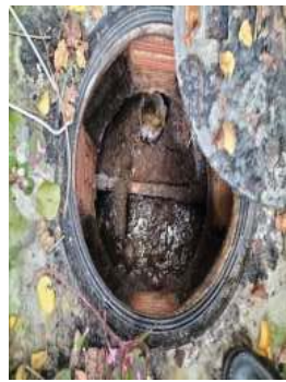
การสูบลูกบอลและสิ่งปฏิกูลจากระบบบำบัดน้ำเสีย
