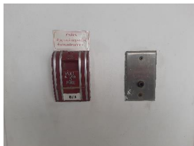
fire alarm manual station และ fireman phone jack
