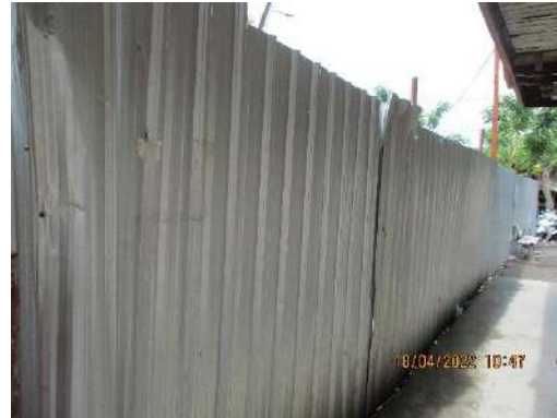
รูปที่ 2-26 (ต่อ) การติดตั้งรั้วบริเวณพื้นที่ก่อสร้าง
