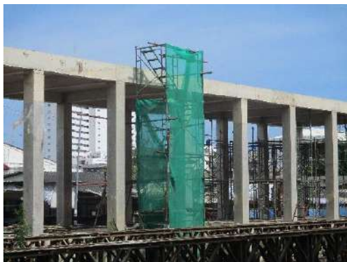
รูปที่ 2-31 การติดตั้งบันได นั่งร้านและราวกันตก
