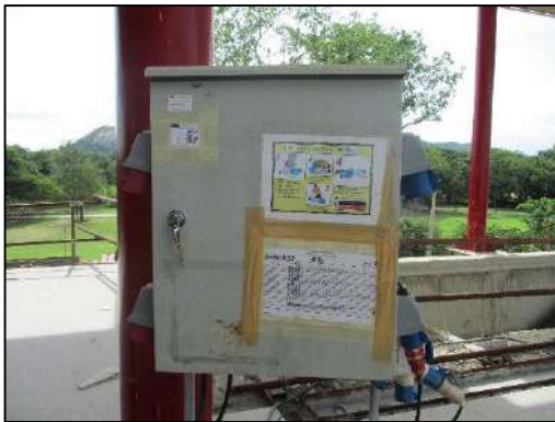
รูปที่ 2-14 (ต่อ) ติดตั้งตู้ควบคุมไฟฟ้าในพื้นที่ก่อสร้าง พร้อมการตรวจเช็คอุปกรณ์ไฟฟ้าที่ใช้ในการทำงาน
