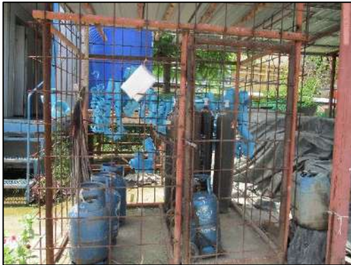
รูปที่ 2-10 จัดเก็บถังแก๊สอย่างเป็นระเบียบเรียบร้อย
