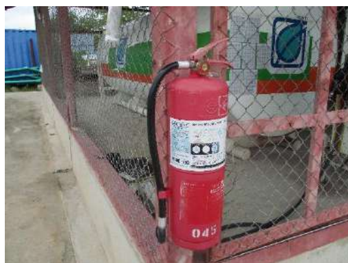
รูปที่ 2-18 การติดตั้งถังดับเพลิง
