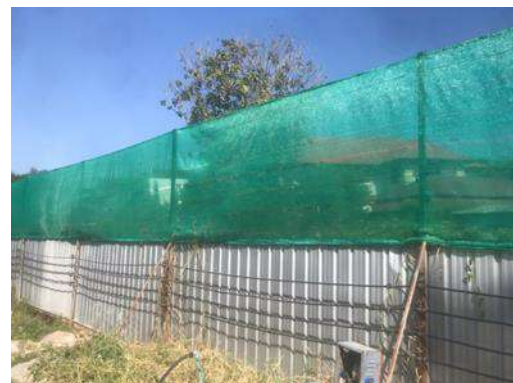
รูปที่ 2-26 การติดตั้งรั้วบริเวณพื้นที่ก่อสร้าง
