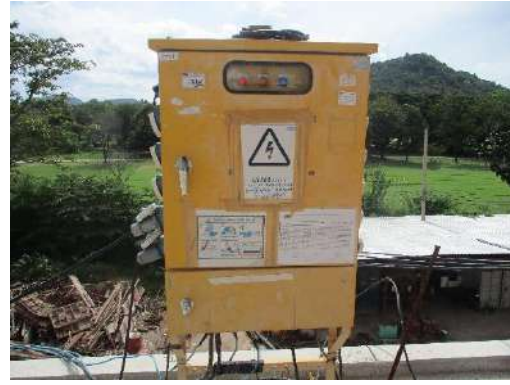
รูปที่ 2-14 (ต่อ) ติดตั้งตู้ควบคุมไฟฟ้าในพื้นที่ก่อสร้าง พร้อมการตรวจเช็คอุปกรณ์ไฟฟ้าที่ใช้ในการทำงาน
