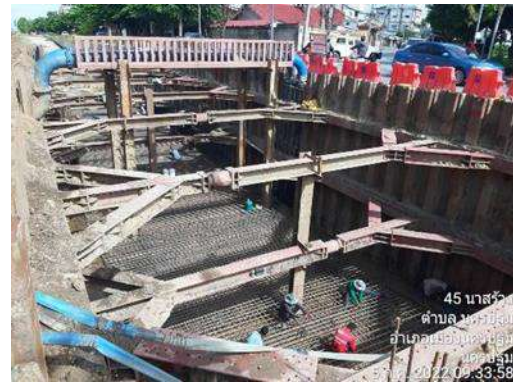
รูปที่ 2-25 การติดตั้ง Sheet Pile เพื่อป้องกันการพังทลายของดิน
