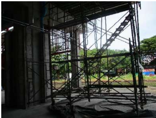
รูปที่ 2-31 การติดตั้งบันได นั่งร้านและราวกันตก
