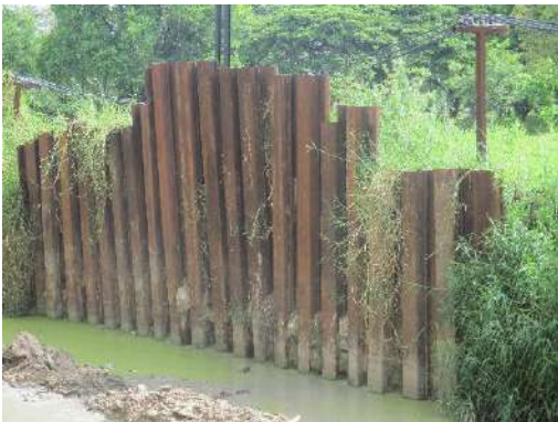
รูปที่ 2-25 การติดตั้ง Sheet Pile เพื่อป้องกันการพังทลายของดิน
