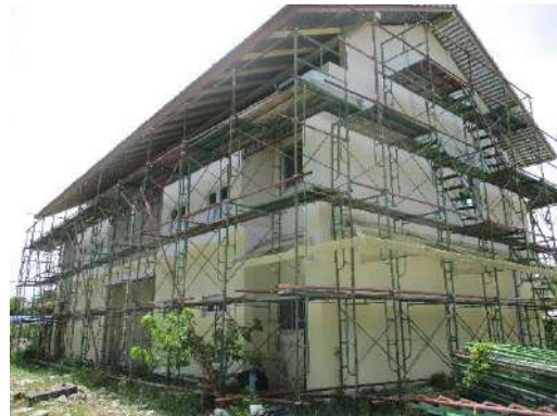
รูปที่ 2-31 การติดตั้งบันได นั่งร้านและราวกันตก
