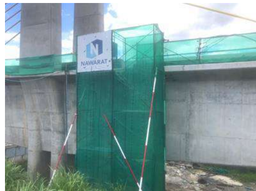
รูปที่ 2-31 การติดตั้งบันได นั่งร้านและราวกันตก
