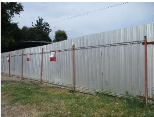
รูปที่ 2-26 การติดตั้งรั้วบริเวณพื้นที่ก่อสร้าง
