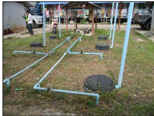
รูปที่ 2-23 ถังบำบัดน้ำเสียสำเร็จรูป บริเวณบ้านพักคนงาน
