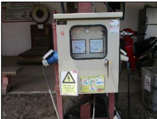
รูปที่ 2-14 ติดตั้งตู้ควบคุมไฟฟ้าในพื้นที่ก่อสร้าง พร้อมการตรวจเช็คอุปกรณ์ไฟฟ้าที่ใช้ในการทำงาน
