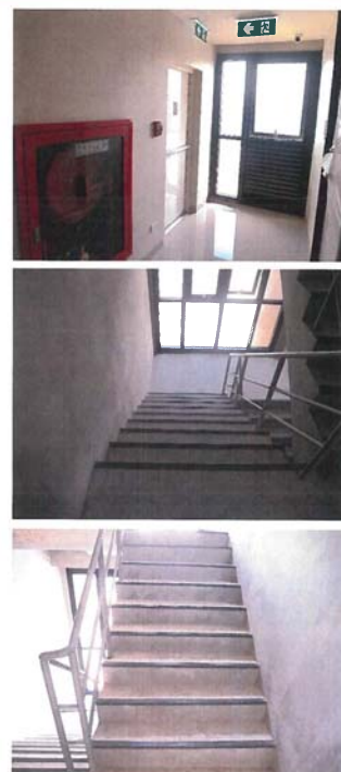
บันไดหนีไฟและเส้นทางหนีไฟ มีระบบแสงสว่าง ไม่มีสิ่งกีดขวาง ผนังหรือประตูทำด้วยวัสดุทนไฟ สามารถใช้หนีภัยในกรณีฉุกเฉินได้
