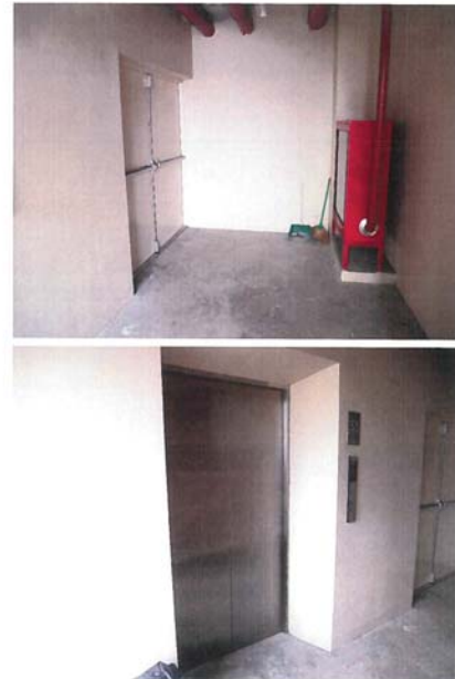
ลิฟต์ดับเพลิงสามารถจอดได้ทุกชั้น มีพื้นที่ไม่น้อยกว่า 6 ตารางเมตรเป็นพื้นที่ปลอดควันและเปลวไฟ ไม่มีสิ่งกีดขวาง และเป็นที่ตั้งของตู้หัวฉีดดับเพลิงประจำชั้นของอาคาร
