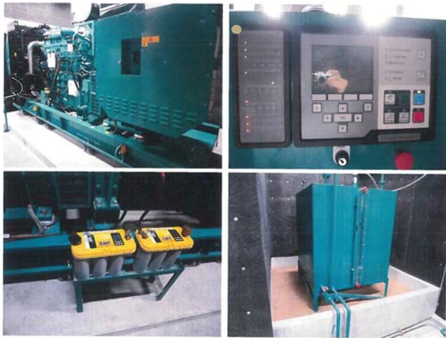
ภาพระบบไฟฟ้าสำรองฉุกเฉินและอุปกรณ์ประกอบ มีการดูแลและตรวจสอบเบื้องต้นจากทางฝ่ายอาคาร
