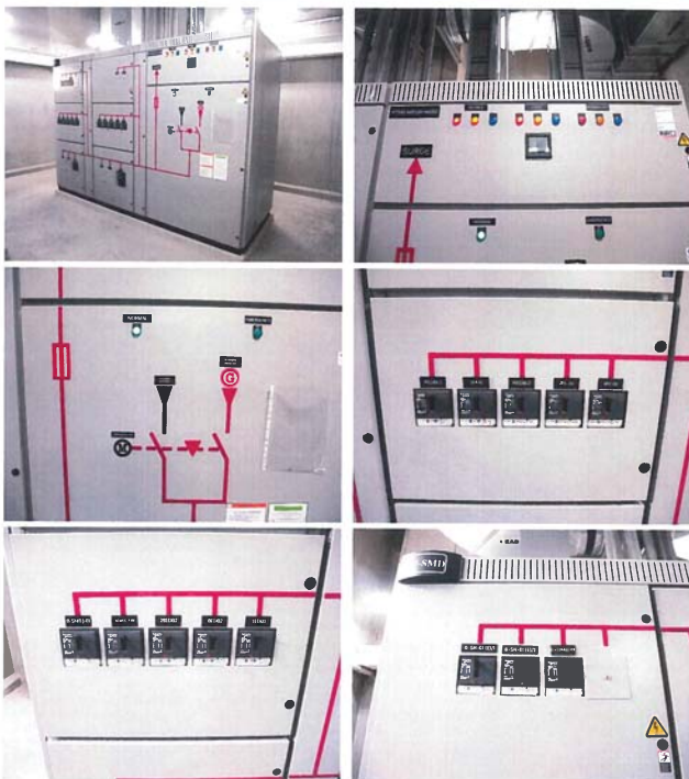
ภาพระบบไฟฟ้าสำรองจ่ายพลังงานไฟฟ้าให้ระบบสำคัญของอาคาร ลิฟต์ดับเพลิง เครื่องสูบน้ำดับเพลิง และพัดลมอัดอากาศเมื่อเกิดเหตุฉุกเฉิน
