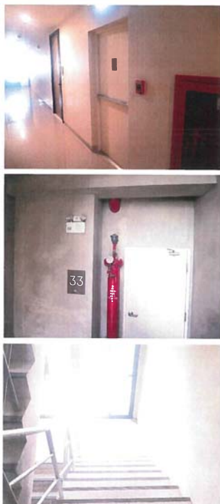
บันไดหนีไฟและเส้นทางหนีไฟ มีระบบแสงสว่าง ไม่มีสิ่งกีดขวาง ผนังหรือประตูทำด้วยวัสดุทนไฟ สามารถใช้หนีภัยในกรณีฉุกเฉินได้
