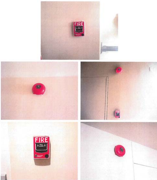
ภาพระบบสัญญาณแจ้งเหตุเพลิงไหม้ด้วยมือและกระดิ่งแจ้งเหตุ มีการตรวจสอบเบื้องต้นจากทางฝ่ายอาคาร
