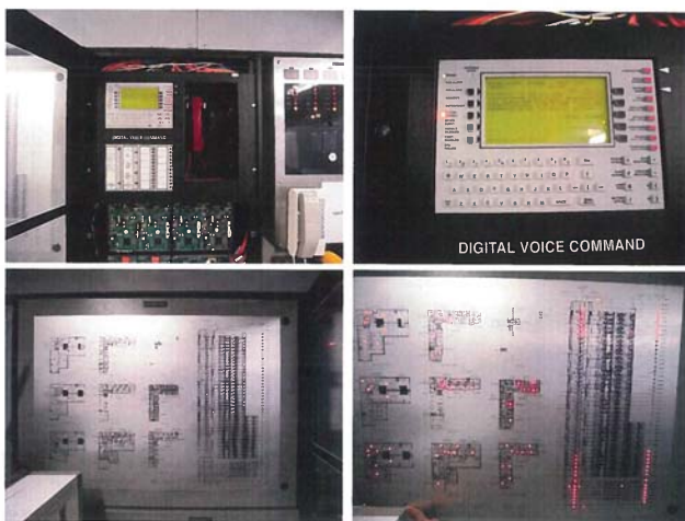
ภาพระบบสัญญาณแจ้งเหตุเพลิงไหม้ตู้ FCP และ Graphic Annunciator มีการตรวจสอบเบื้องต้นจากทางฝ่ายอาคาร
