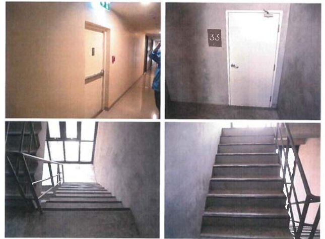
บันไดหนีไฟและเส้นทางหนีไฟ มีระบบแสงสว่าง ไม่มีสิ่งกีดขวาง ผนังหรือประตูทำด้วยวัสดุทนไฟ สามารถใช้หนีภัยในกรณีฉุกเฉินได้
