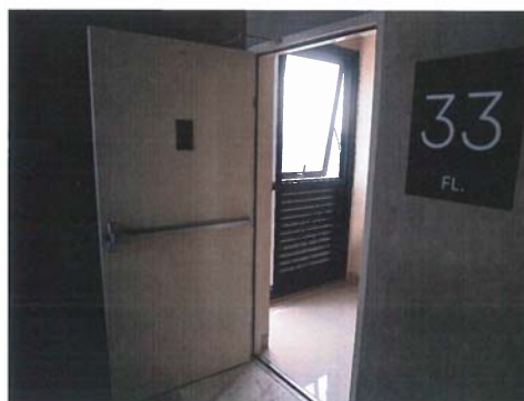
ตรวจสอบ วางแผนการจัดการและให้ข้อมูลผู้ใช้อาคารเรื่องการปิดประตูปันไดหนีไฟ ไม่ควรเปิดค้างและควรติดตั้ง Door Closer ให้สามารถปิดสนิทได้ด้วยตัวเอง
