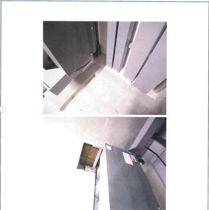
การปิดช่องเปิดระหว่างชั้น (ชาร์ปงานระบบ) ป้องกันการแพร่กระจายควันไฟ
