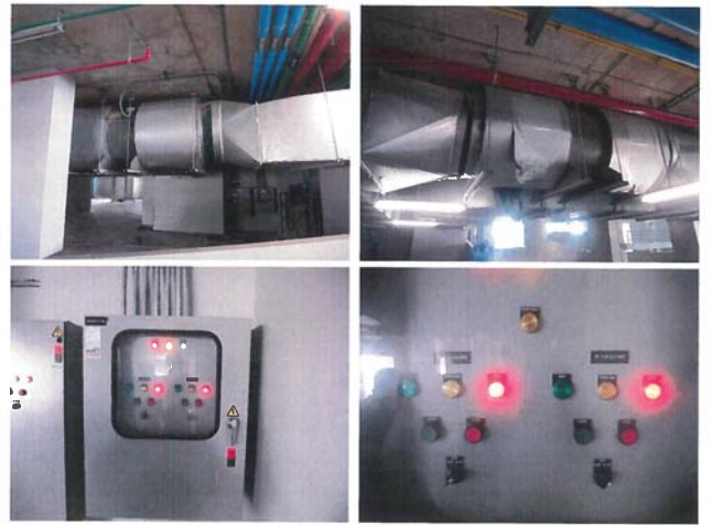
ภาพระบบพัดลมอัดอากาศและอุปกรณ์ประกอบ มีการตรวจสอบและดูจากช่างอาคาร
