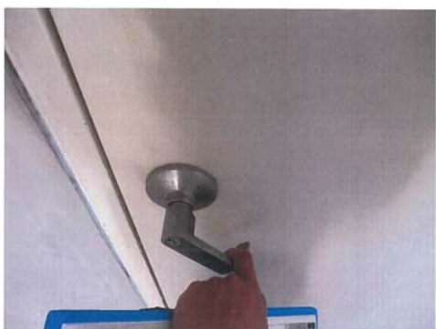
ตรวจสอบ วางแผนการอพยพและเข้าช่วยเหลือให้ชัดเจน เนื่องจากประตูหนีไฟไม่สามารถเปิดกลับเข้าตัวอาคารได้
