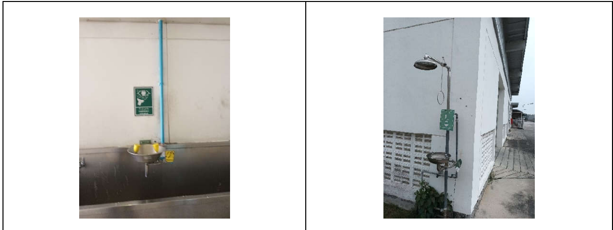
รูปถ่ายที่ 3.2-41 : ฝักบัวฉุกเฉินและอ่างล้างตา
