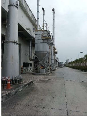
รูปถ่ายที่ 3.2-1 : ระบบดักฝุ่นแบบถุงกรอง
