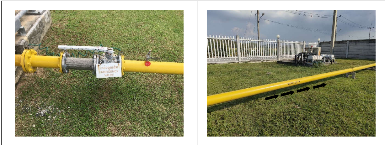
รูปถ่ายที่ 3.2-51 : ป้ายแสดงทิศทางการหมุนวาล์ว และแสดงทิศทางการไหลในท่อขนส่ง
