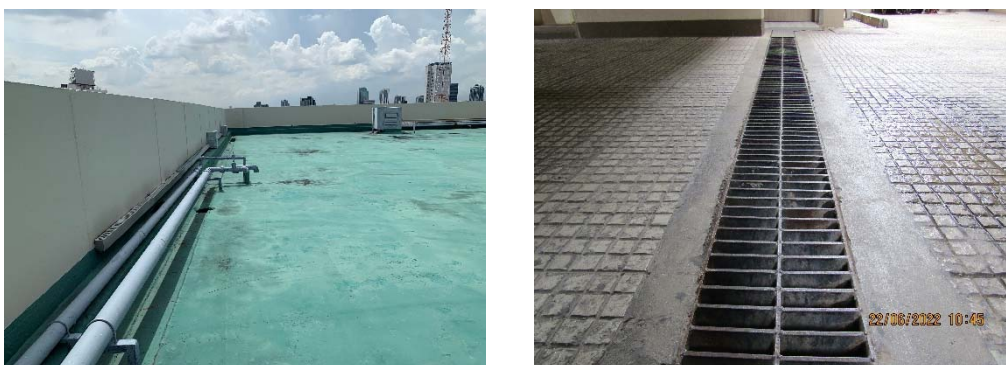
ภาพที่ 2.2-7 การระบายน้ำภายในโครงการ
