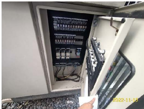
แผงควบคุมเครื่องสูบน้ำบ่อหนองน้ำ
