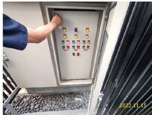
แผงควบคุมเครื่องสูบน้ำบ่อหนองน้ำ
