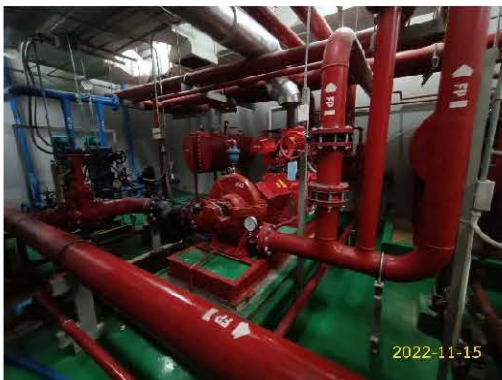
เครื่องสูบน้ำดับเพลิงชุด Low Zone
