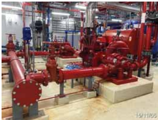
ระบบน้ำสำรองดับเพลิงและเครื่องสูบน้ำดับเพลิง
