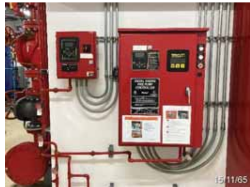
ระบบน้ำสำรองดับเพลิงและเครื่องสูบน้ำดับเพลิง
