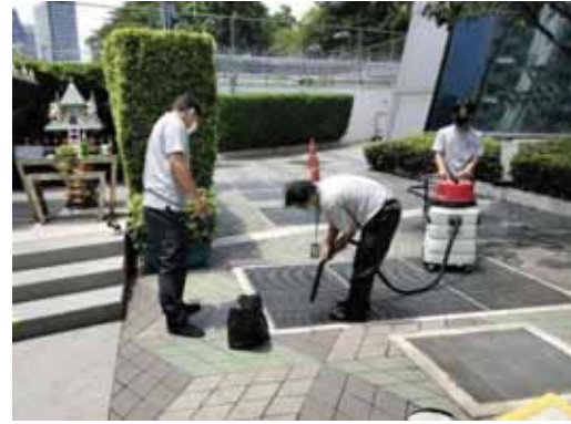
การทำความสะอาดและตัดเศษขยะออกจากตะแกรงดักขยะ ภาพที่ 2.2-10 (ต่อ) การจัดการระบบระบายน้ำและป้องกันน้ำท่วม
