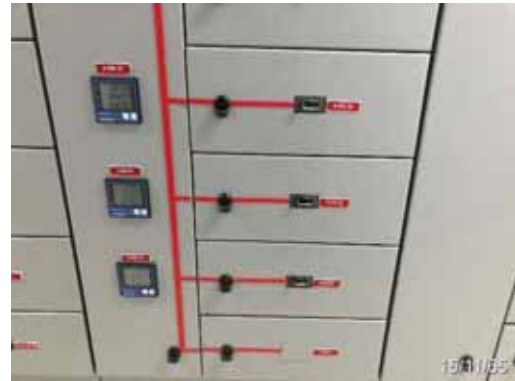
มิเตอร์ไฟระบบบำบัดน้ำเสีย
