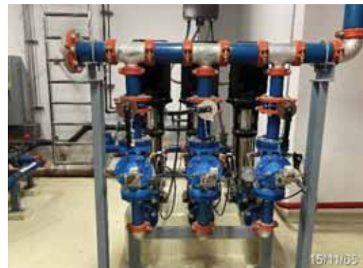
เครื่องสูบน้ำ Reuse
