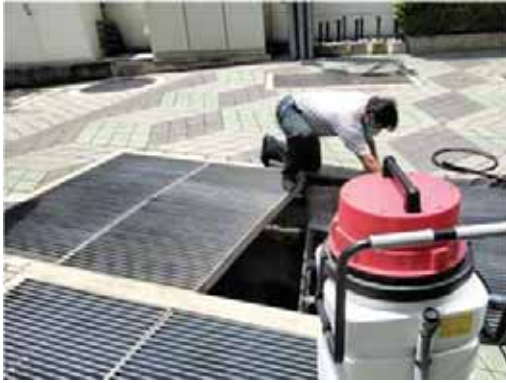
การทำความสะอาดและตัดเศษขยะออกจากตะแกรงดักขยะ ภาพที่ 2.2-10 (ต่อ) การจัดการระบบระบายน้ำและป้องกันน้ำท่วม
