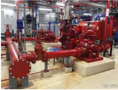
ระบบน้ำสำรองดับเพลิงและเครื่องสูบน้ำดับเพลิง
