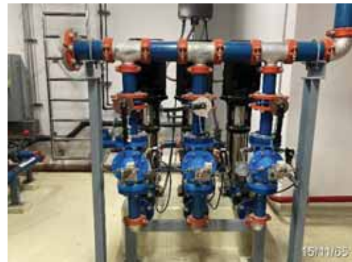
เครื่องสูบน้ำ Reuse
