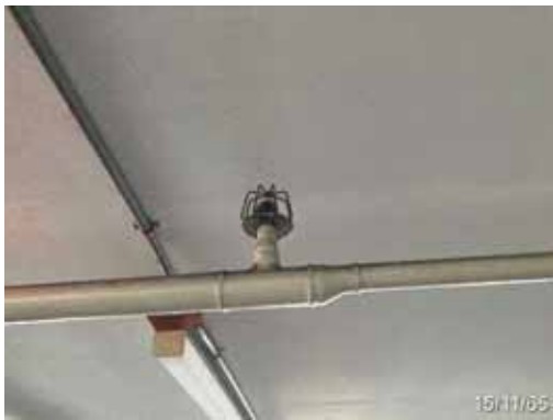
หัวกระจายน้ำดับเพลิง (Sprinkler System)
