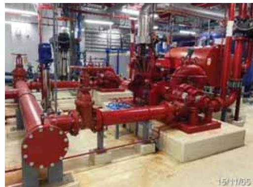
ระบบสำรองน้ำดับเพลิงชั้นใต้ดิน
