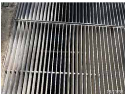
ตะแกรงดักขยะบ่อสุดท้ายก่อนออกจากโครงการ
