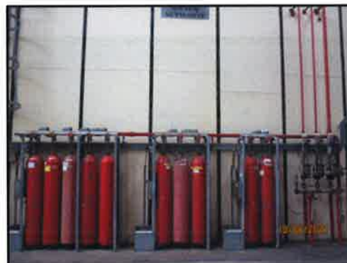
Fire Extinguisher ชนิด Carbon Dioxide
