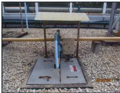
รูปที่ 3-12 ถังบำบัดน้ำเสียสำเร็จรูป (Septic Tank)
