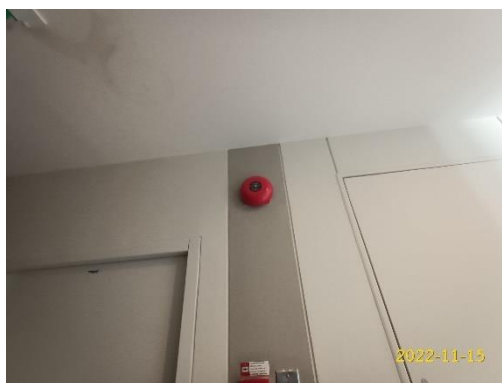
อุปกรณ์ส่งเสียงสัญญาณแบบกระดิ่ง
