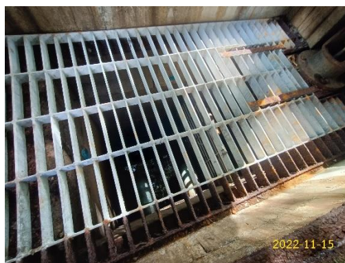
บ่อพักน้ำสุดท้ายก่อนระบายออกนอกโครงการ/ตะแกรงดักมูลฝอย
