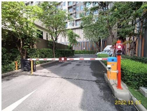
ระบบบัตรอิเล็กทรอนิกส์สำหรับเข้าออก
