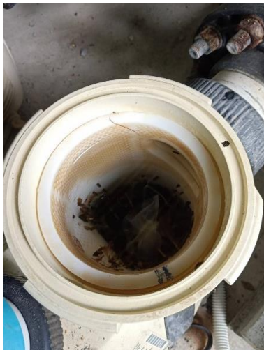
การทำความสะอาดเครื่องกรองสรวายน้ำ
