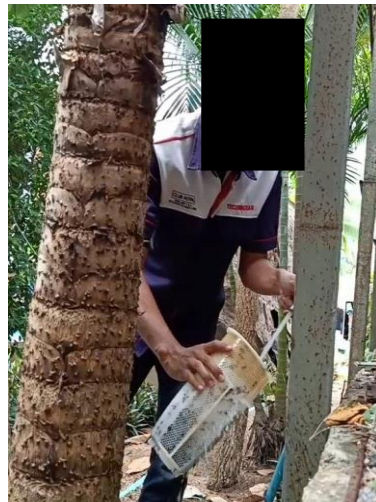
การทำความสะอาดเครื่องกรองสรวายน้ำ
