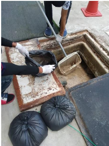
การตัดไขมันระบบบำบัดน้ำเสีย
