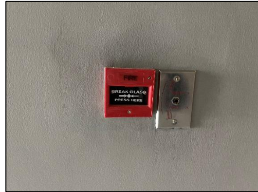
รูปที่ 2-37 ติดตั้งเครื่องแจ้งเหตุโดยใช่มือดึง
