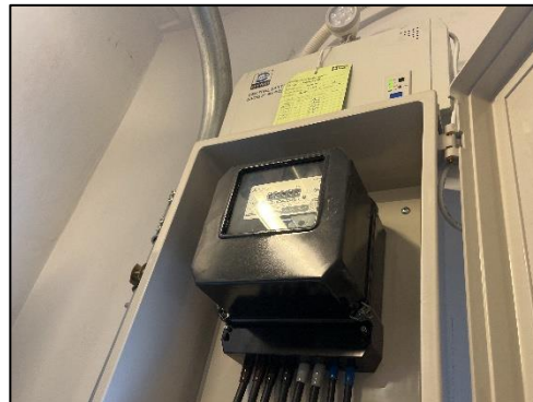
รูปที่ 2-10 ระบบมิเตอร์ไฟฟ้าสำหรับระบบบำบัดน้ำเสีย
