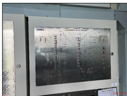
รูปที่ 2-33 แผงควบคุม (Fire Alarm Control Panel: FCP)
