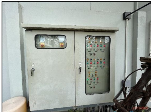
รูปที่ 2-10 ระบบมิเตอร์ไฟฟ้าสำหรับระบบบำบัดน้ำเสีย
