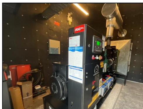
รูปที่ 2-26 เครื่องกำเนิดไฟฟ้า และไฟฟ้าส่องสว่างฉุกเฉิน
