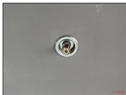
รูปที่ 2-35 ติดตั้งหัวกระจายน้ำดับเพลิงอัตโนมัติ
