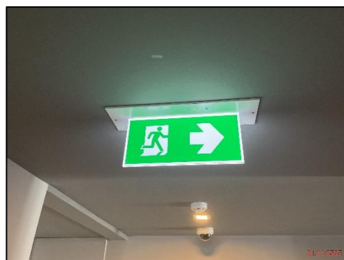
รูปที่ 2-43 ติดตั้งป้ายบอกทางออกฉุกเฉิน
