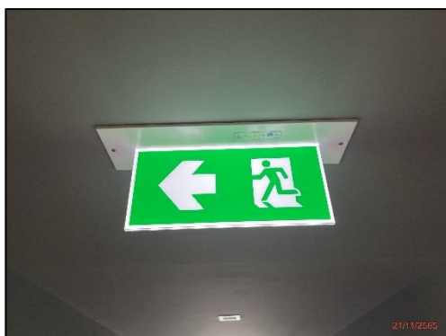
รูปที่ 2-43 ติดตั้งป้ายบอกทางออกฉุกเฉิน
