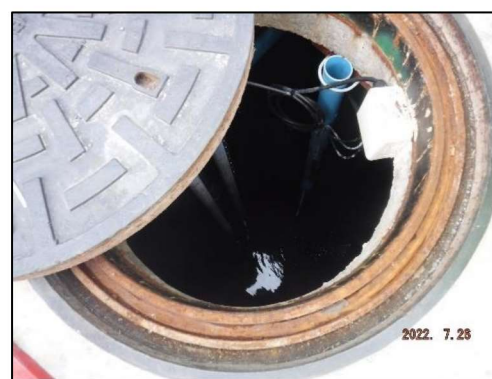
(2) ถังพักน้ำใส-สูบลอกของระบบบำบัด (หลังการบำบัด) อาคาร A
