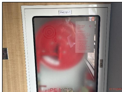
รูปที่ 2-32 ตู้เก็บสายฉีดน้ำดับเพลิงพร้อมอุปกรณ์ (Fire Hose Cabinet : FHC)
