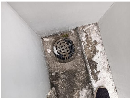
ตะแกรงครอบราง/ท่อระบายน้ำ
