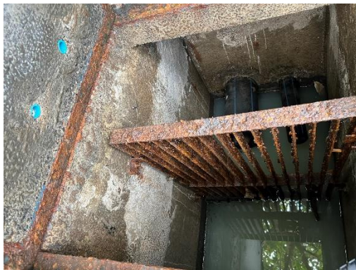
ตะแกรงดักมูลฝอยบริเวณบ่อพักน้ำสุดท้าย
