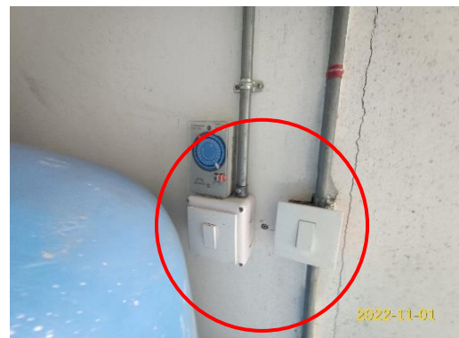
แยกสวิทช์ควบคุมอุปกรณ์ไฟฟ้าส่องสว่าง
