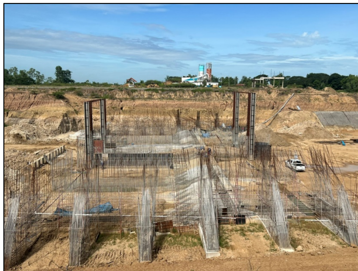
ภาพที่ 1.7-1 การก่อสร้างประตูระบายน้ำห้วยงานและอาคารประกอบ
