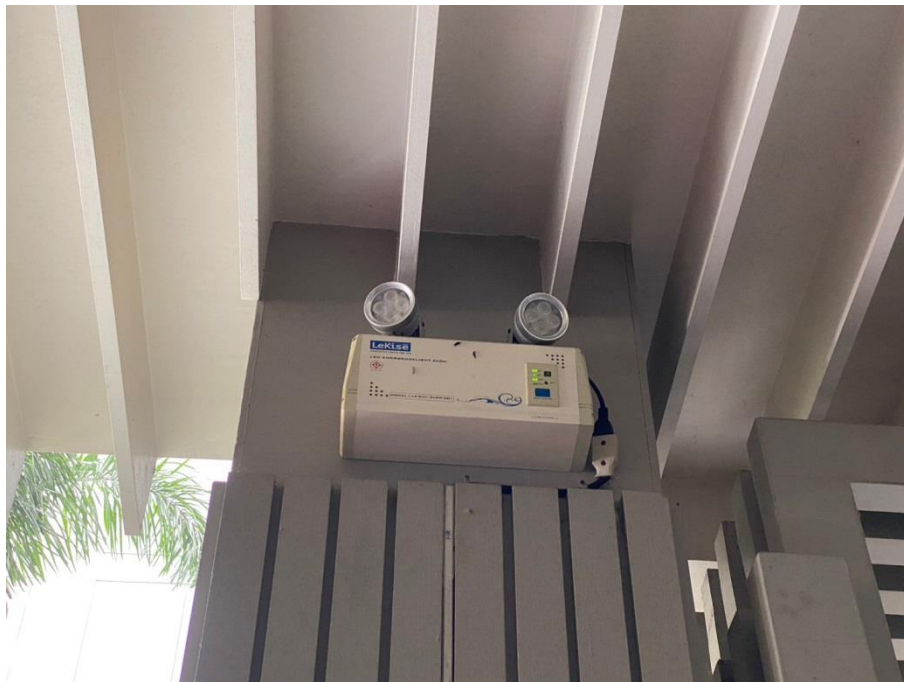
ภาพที่ 9 แสดงไฟส่องสว่างฉุกเฉิน
