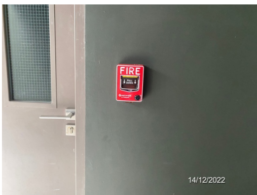
อุปกรณ์แจ้งเหตุด้วยมือ (Fire Alarm Manual Station)
