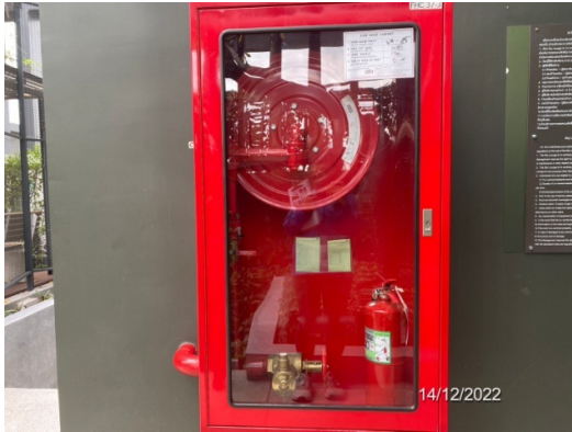
ตู้สายฉีดน้ำดับเพลิง (Fire Hose Cabinet : FHC)
