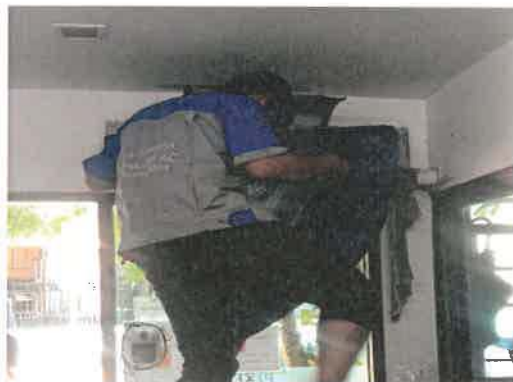
การล้างแผ่นกรองอากาศและเครื่องปรับอากาศ
