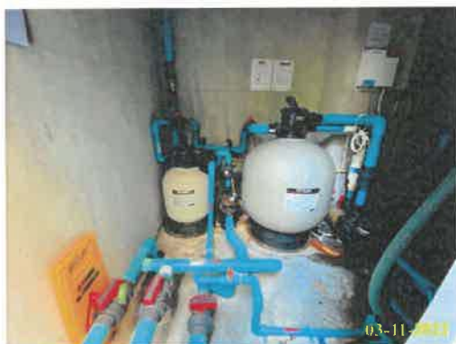
ระบบกรองและฆ่าเชื้อสระว่ายน้ำ
