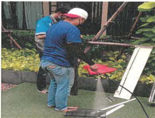
การล้างแผ่นกรองอากาศและเครื่องปรับอากาศ
