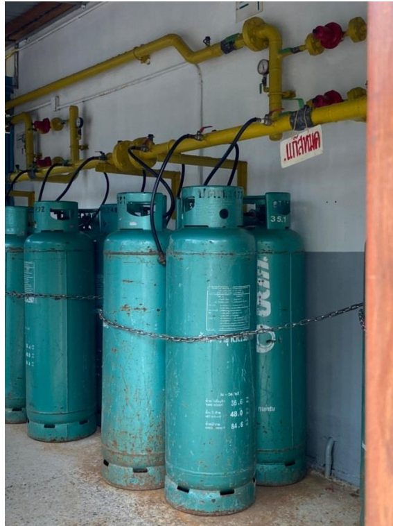
ภาพที่ 23 แสดงการรัดถังก๊าซ ภายในห้องเก็บก๊าซหุงต้ม
