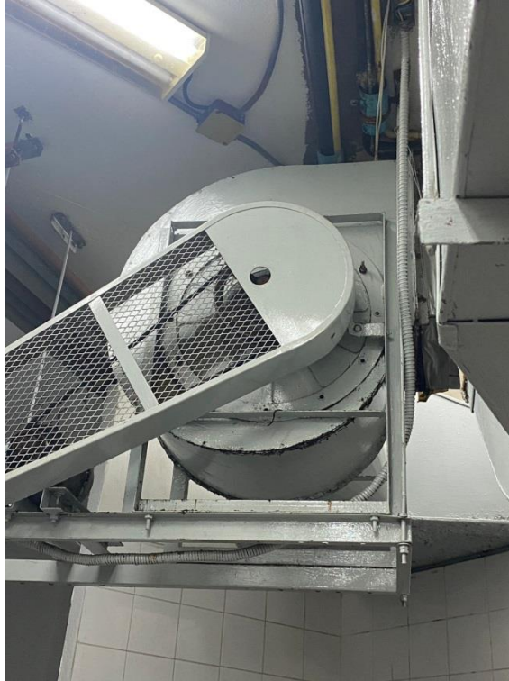
ภาพที่ 27 แสดงพัดลมดูดอากาศ
