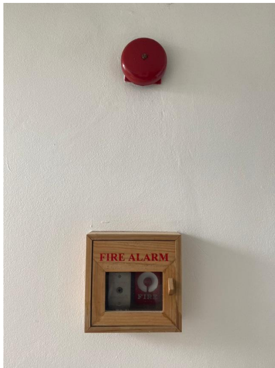
ภาพที่ 12 แสดงสัญญาณเตือนภัยด้วยมือ
