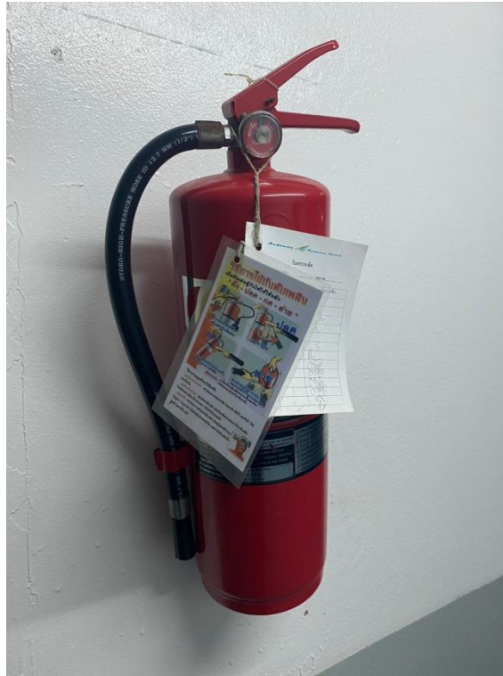
ภาพที่ 11 แสดงถังดับเพลิงชนิดเคมีผงแห้งและวิธีการใช้
