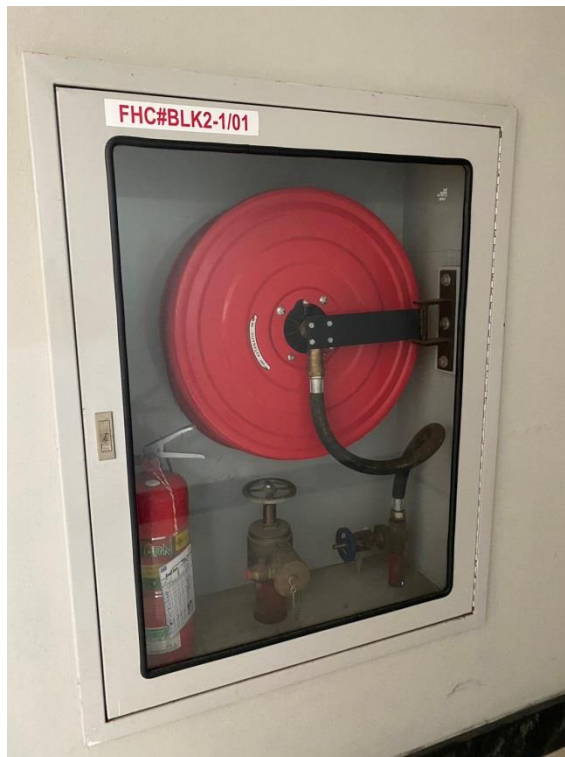
ภาพที่ 22 แสดงตู้เก็บอุปกรณ์ดับเพลิง
