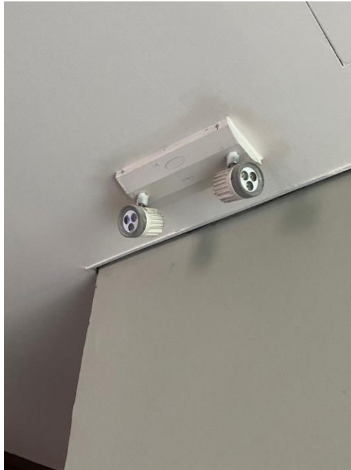
ภาพที่ 35 แสดงไฟส่องสว่างฉุกเฉิน
