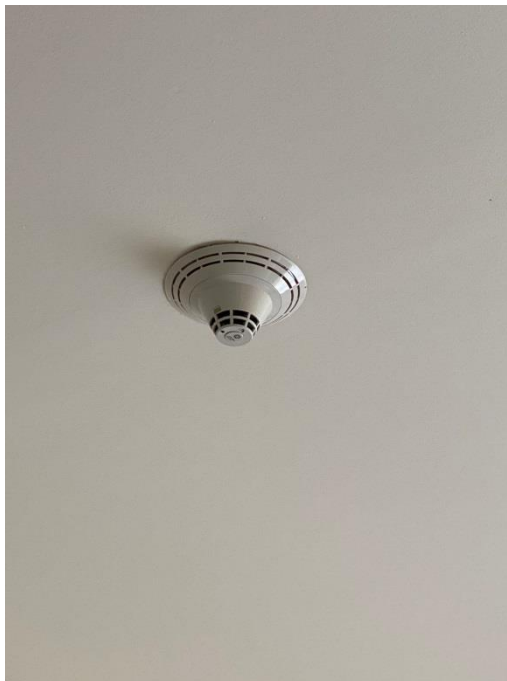
ภาพที่ 16 แสดงเครื่องตรวจจับควัน (Smoke detector)
