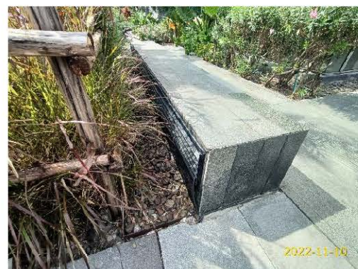
ช่องระบายอากาศชั้นจอดรถใต้ดินอาคาร A
