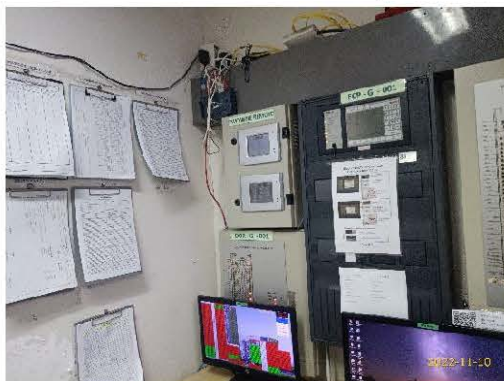
ระบบเปิด-ปิด ไฟฟ้าส่องสว่างส่วนกลาง
