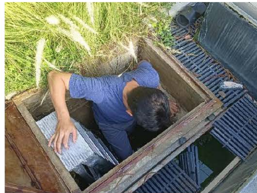
การทำความสะอาดท่อระบายน้ำ
