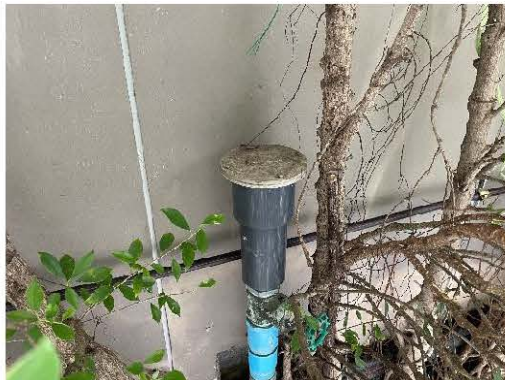
ระบบเติมอากาศระบบบำบัดน้ำเสีย
