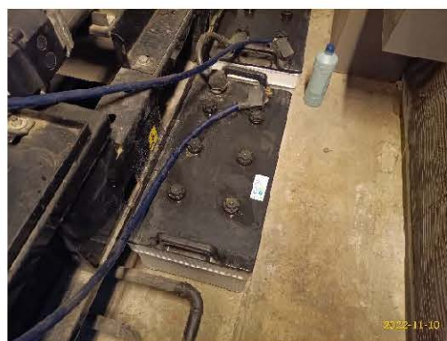
แบตเตอรี่สำรองไฟฟ้า
