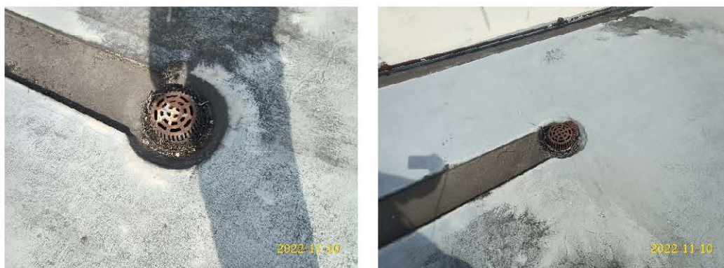
ระบบระบายน้ำฝนจากหลังคาอาคาร
