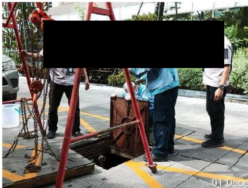
การเก็บตัวอย่างคุณภาพน้ำทิ้งก่อนการบำบัด บริเวณบ่อปรับสภาพน้ำ
