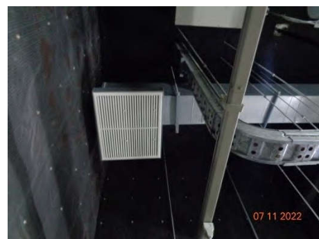
ภาพที่ 2.2-20 การติดตั้งตะแกรง Gravity Shutter
