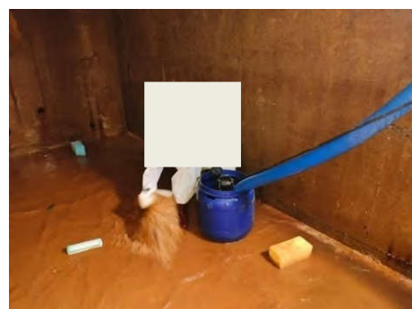
ภาพที่ 2.2-13 การทำความสะอาดถังเก็บน้ำชั้นใต้ดินและชั้นหลังคา
