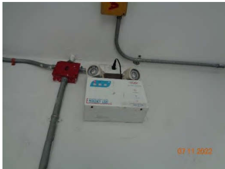
ภาพที่ 2.2-17 ระบบไฟฟ้าฉุกเฉิน
