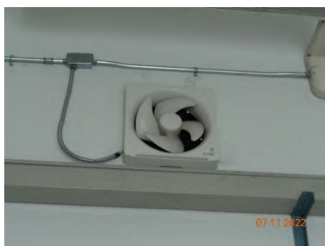
ภาพที่ 2.2-26 พัดลมระบายอากาศ
