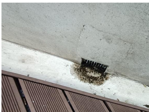
ท่อรวบรวมน้ำพร้อมตะแกรงปิด
