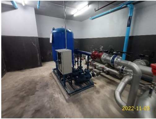
ระบบปั้มน้ำใช้ชั้นดาดฟ้า
