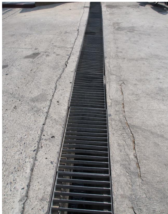
ภาพที่ 18 แสดงรางระบายน้ำ ตะแกรงคักขะ
