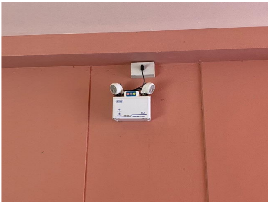
ภาพที่ 12 แสดงเครื่องสำรองไฟฉุกเฉิน
