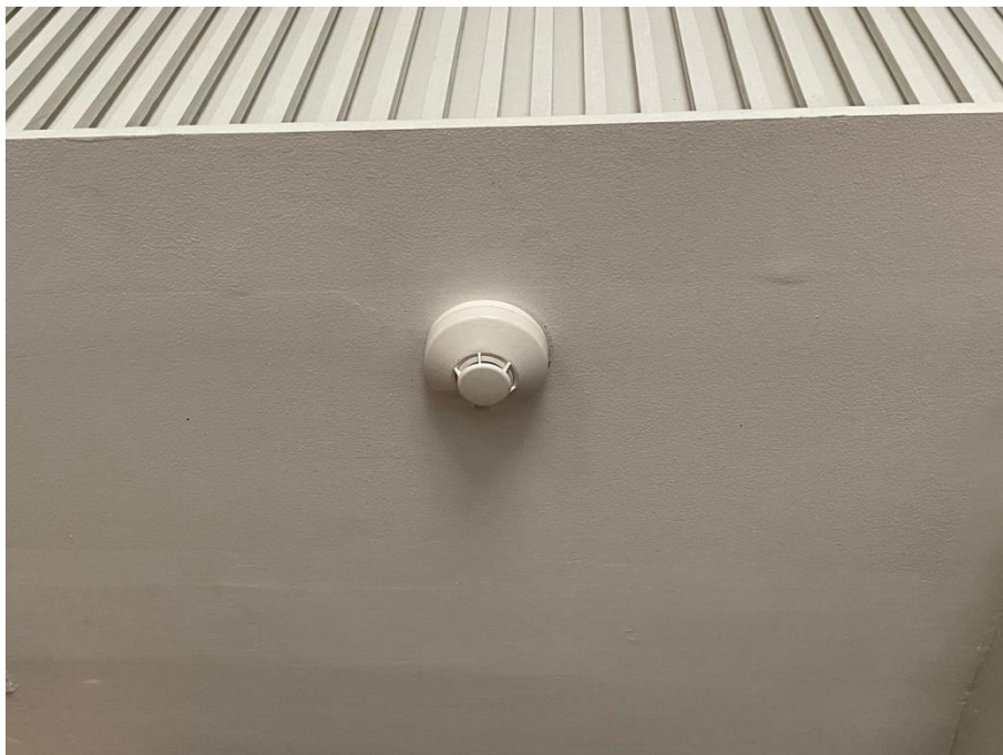
ภาพที่ 26 แสดงเครื่องตรวจจับควัน (Smoke Detector)
