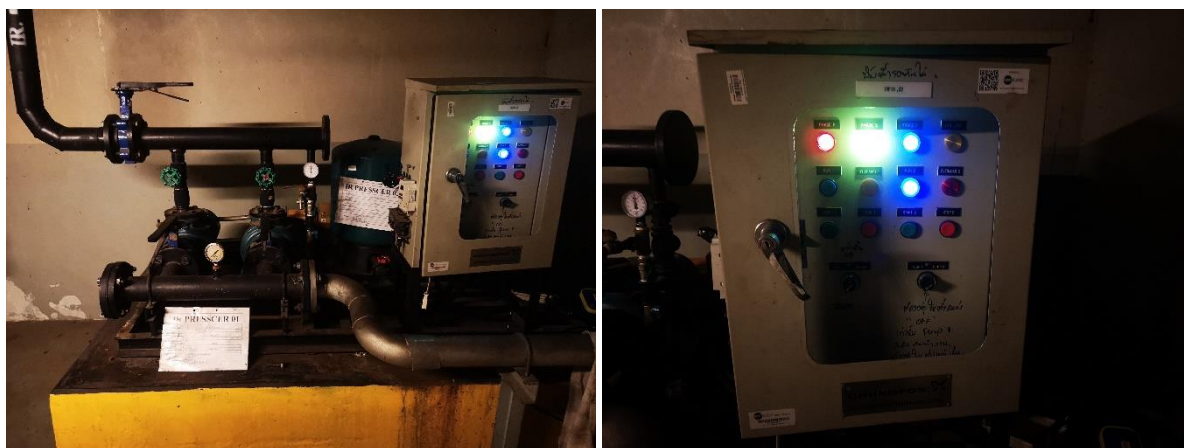
รูปที่ 3-12 เครื่องสูบน้ำหมุนเวียนกลับมาใช้ใหม่และถังเก็บน้ำหมุนเวียนกลับมาใช้ใหม่
