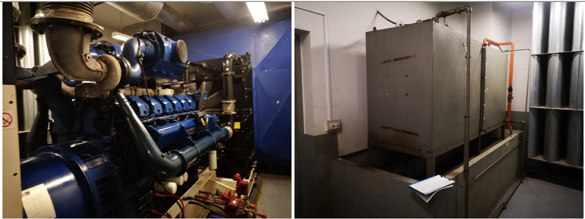
รูปที่ 2-9 เครื่องกำเนิดไฟฟ้าฉุกเฉินโดยเครื่องยนต์ดีเซล ขนาด 1500 KVA
