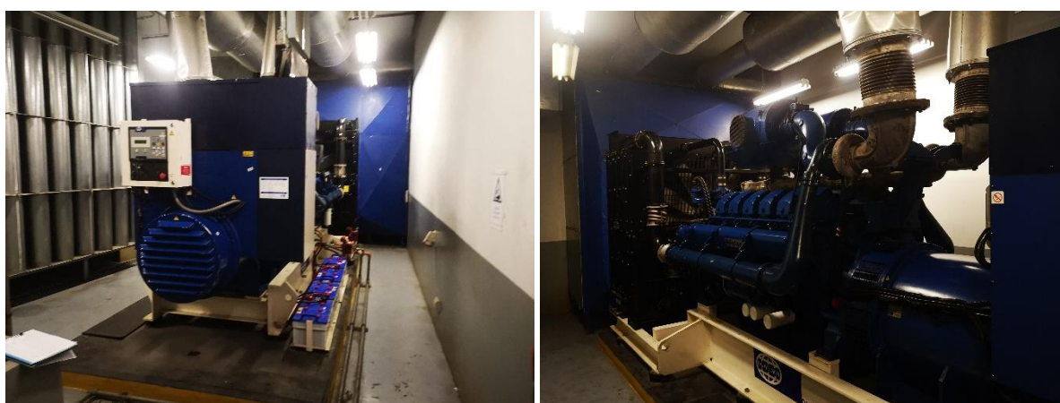
รูปที่ 3-15 เครื่องยนต์ผลิตไฟฟ้าสำรองใช้ดีเซล ขนาด 1,200 kW
