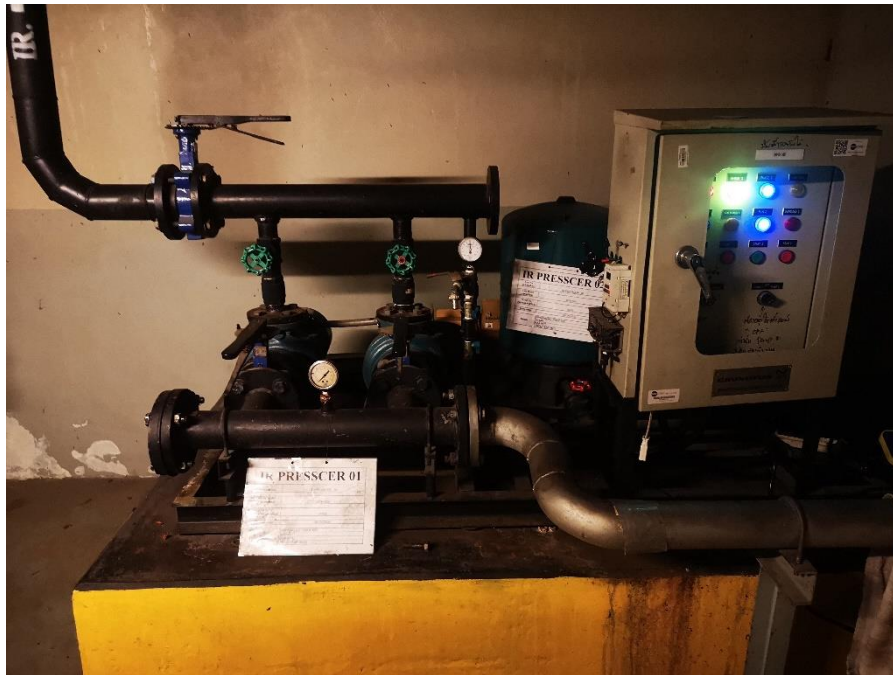
รูปที่ 2-5 เครื่องสูบน้ำหมุนเวียนกลับมาใช้ใหม่และดึงเก็บน้ำหมุนเวียนกลับมาใช้ใหม่
