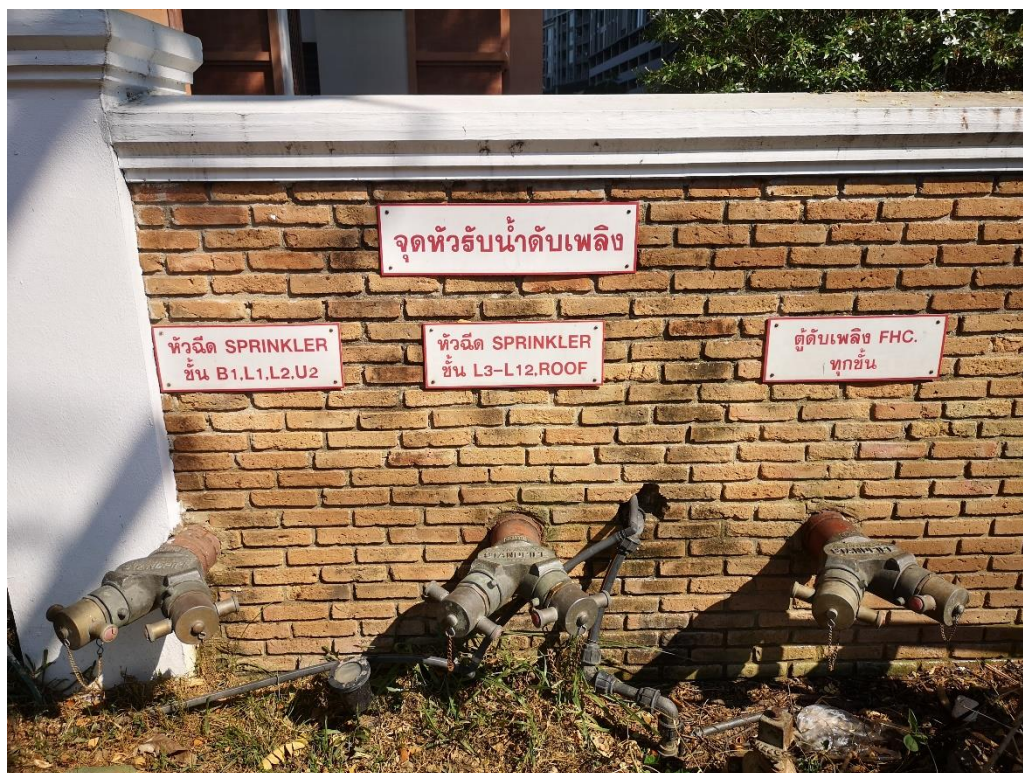
รูปที่ 3-14 หัวรับน้ำดับเพลิงชนิดเชื่อมต่อสวมเร็วติดตั้งภายนอกอาคาร
