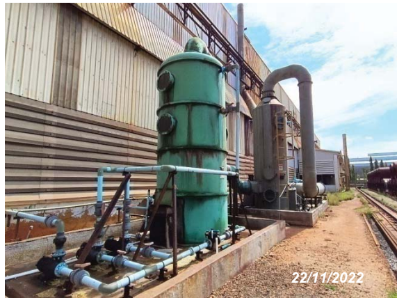
ระบบบำบัดอากาศแบบ Wet Scrubber
