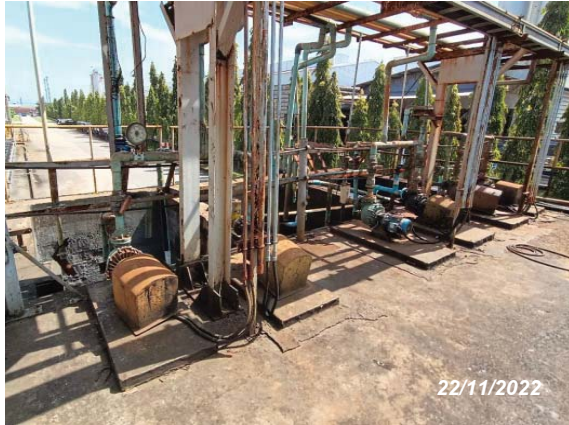
ระบบบำบัดน้ำเสียที่ปนเปื้อน Heavy Oil และ Emulsion Oil
