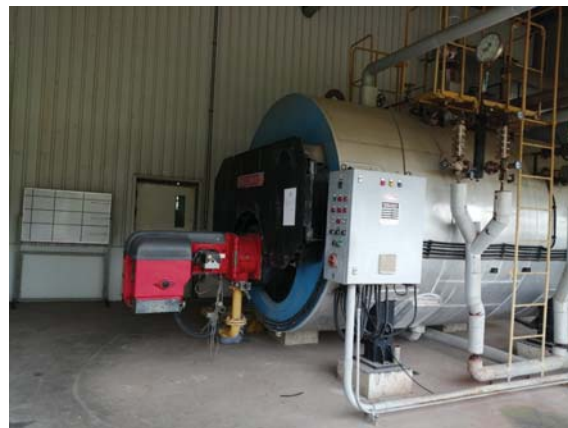
หม้อไอน้ำ (Boiler)
