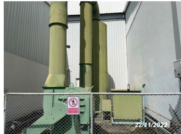
ระบบบำบัดอากาศแบบ Wet Scrubber
