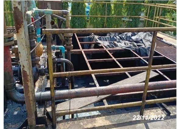
ระบบบำบัดน้ำเสียที่ปนเปื้อน Heavy Oil และ Emulsion Oil
