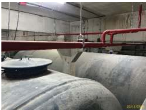
ถังเก็บน้ำขึ้นดาดฟ้า พร้อมเครื่องปั้มน้ำขึ้นดาดฟ้า
