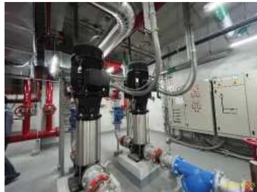
ถังเก็บน้ำใต้ดิน พร้อมเครื่องสูบน้ำขึ้นใต้ดิน
