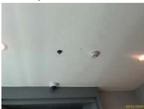
เครื่องตรวจจับควันและหัวกระจายน้ำดับเพลิง
