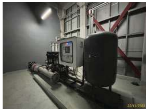
ถังเก็บน้ำขึ้นดาดฟ้า พร้อมเครื่องปั้มน้ำขึ้นดาดฟ้า
