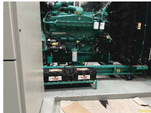
แบตเตอรี่เครื่องกำเนิดไฟฟ้า
