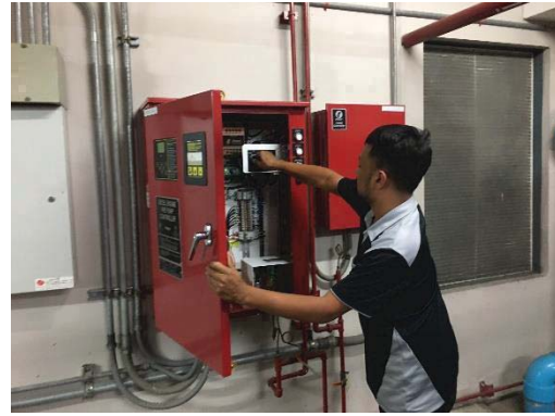
ตรวจเช็ค/ซ่อมบำรุงระบบป้องกันอัคคีภัย
