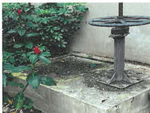
บ่อกักน้ำสุดท้ายก่อนระบายออกลงรางสาธารณะ
