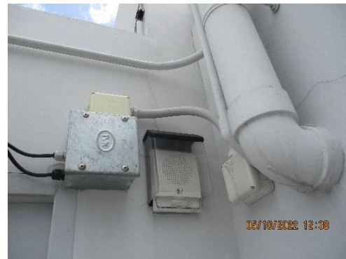
อุปกรณ์ส่งสัญญาณแจ้งเหตุแบบกริ่งสัญญาณ (Alarm Bel)
