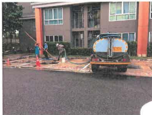
ดูดำจัดจัดตะกอนระบบบำบัดน้ำเสีย
