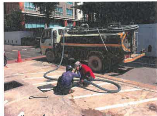
ดูดำจัดจัดตะกอนระบบบำบัดน้ำเสีย
