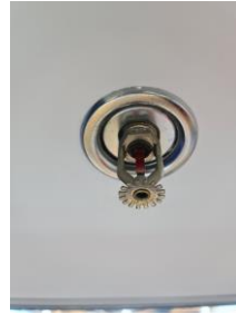
ระบบหัวดับเพลิงอัตโนมัติ Sprinkle
