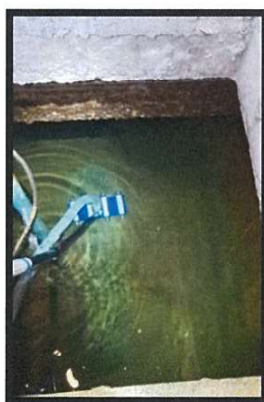
No.5 แสดงสภาพบ่อน้ำหลังทำความสะอาด
