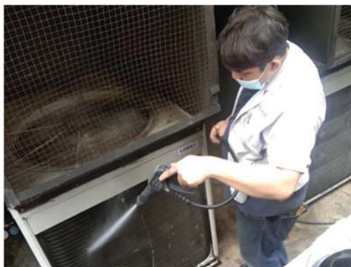
การทำความสะอาดระบบปรับอากาศ
