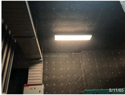
ผนังกันเสียงห้องเครื่องกำเนิดไฟฟ้า
