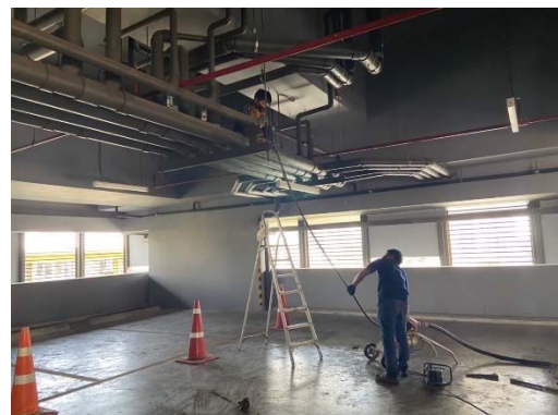
ตรวจสอบและทำความสะอาดระบบระบายน้ำ
