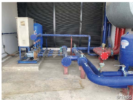
ระบบปั๊มและถังเก็บน้ำชั้นตาดฟ้า
