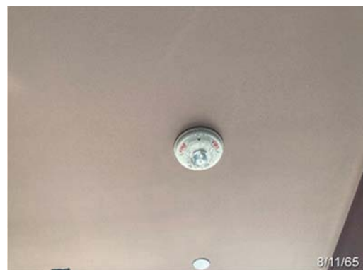
อุปกรณ์แจ้งเหตุด้วยเสียงและแสง
