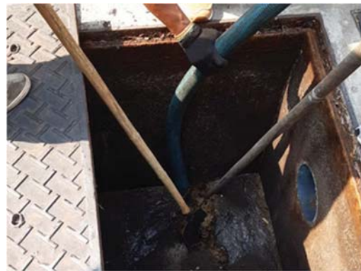
การสูบน้ำทิ้งระบบบำบัดน้ำเสีย
