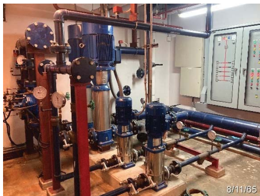
ระบบปั๊มและถังเก็บน้ำขึ้นใต้ดิน
