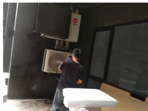
การทำความสะอาดระบบปรับอากาศ
