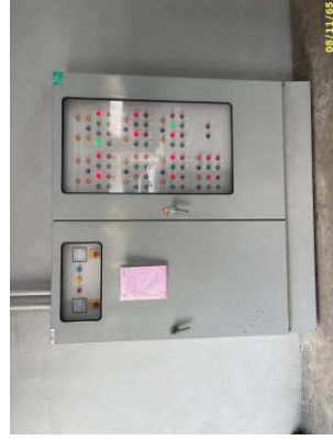
พื้นที่ระบบบำบัดน้ำเสีย พร้อมตู้ควบคุมระบบบำบัดน้ำเสียอาคาร B
