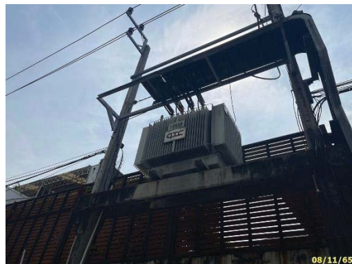
หม้อแปลงไฟฟ้าขนาด 1000 KVA อาคาร B
