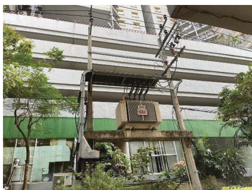
หม้อแปลงไฟฟ้าขนาด 1000 KVA อาคาร C
