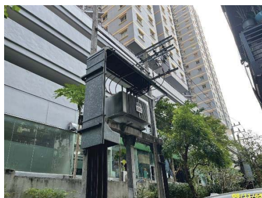
หม้อแปลงไฟฟ้าขนาด 1250 KVA อาคาร D
