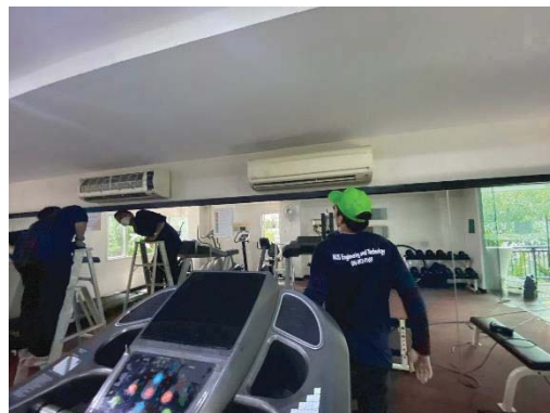
ทำความสะอาดเครื่องปรับอากาศพื้นที่ส่วนกลาง
