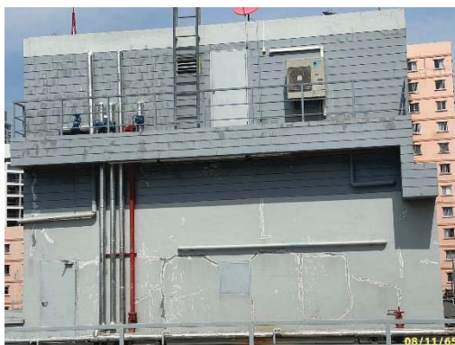
ถังเก็บน้ำขึ้นดาดฟ้า พร้อมเครื่องปั้มน้ำ
