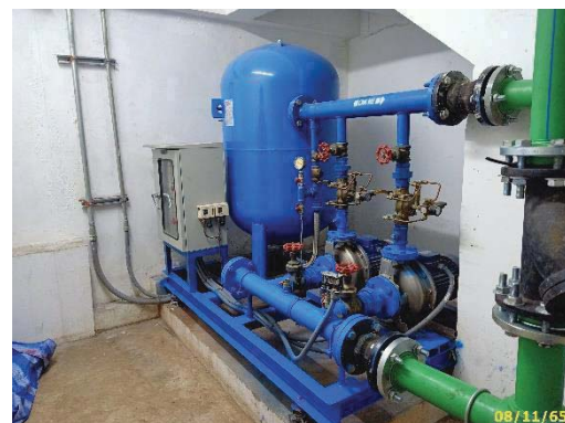
ถังเก็บน้ำขึ้นดาดฟ้า พร้อมเครื่องปั้มน้ำ
