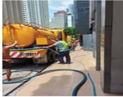
การสูบล้างส่วนเกินระบบบำบัดน้ำเสีย
