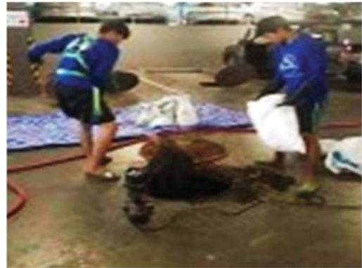
การตักกากตะกอนไขมันจากถังดักไขมัน
