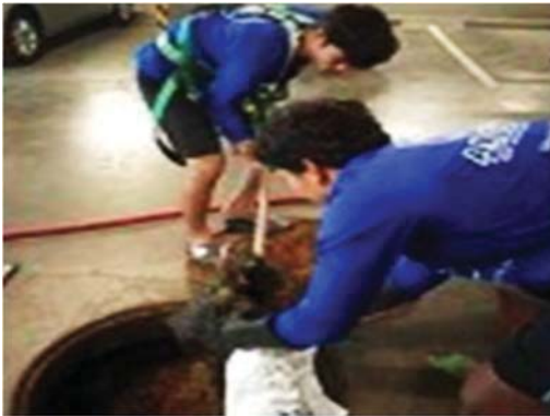
การตักกากตะกอนไขมันจากถังดักไขมัน
