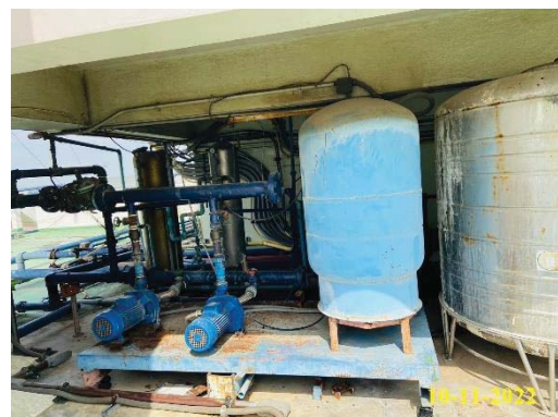
ถังสำรองน้ำขึ้นดาดฟ้า Booster Pump อาคาร B
