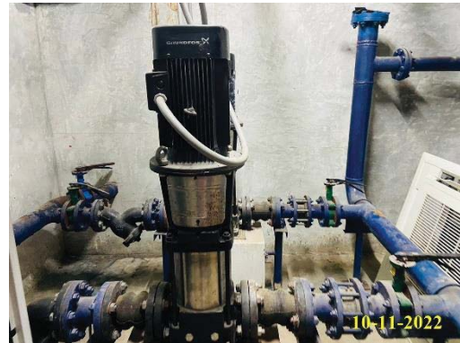
ปั๊มสูบน้ำอาคาร C
