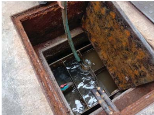
การดักไขมันและสูบน้ำตะกอนระบบบำบัดน้ำเสีย
