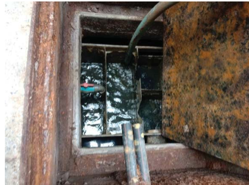
การดักไขมันและสูบน้ำตะกอนระบบบำบัดน้ำเสีย
