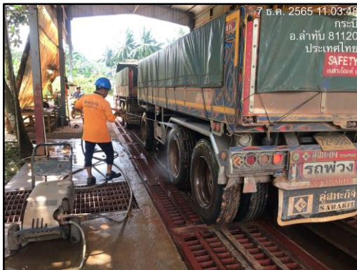
ภาพที่ 2.8 บ่อล้างล้อ และการล้างทำความสะอาดบรรทุก
