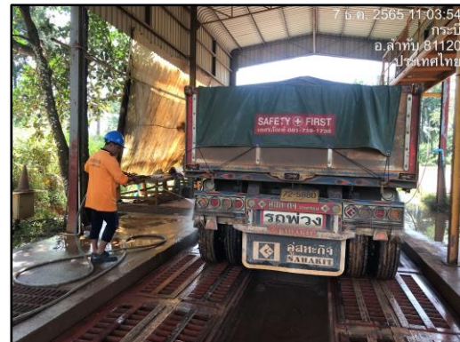
ภาพที่ 2.8 บ่อล้างล้อ และการล้างทำความสะอาดบรรทุก
