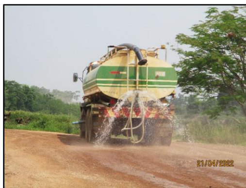
ภาพที่ 2.24 การฉีดพรมน้ำบริเวณหน้าเหมือง และเส้นทางการลำเลียงแร่ภายในพื้นที่โครงการ
