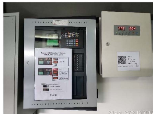
ภาพที่ 2-72 แผงควบคุมระบบแจ้งเหตุเพลิงไหม้ (Fire Alarm Control Panel ; FCP)
