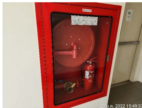
ภาพที่ 2-65 ตู้เก็บสายฉีดน้ำดับเพลิง (Fire Hose Cabinet)
