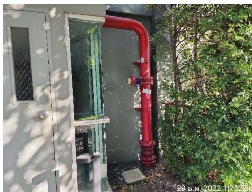
ภาพที่ 2-64 ท่อยืนสำหรับดับเพลิง
