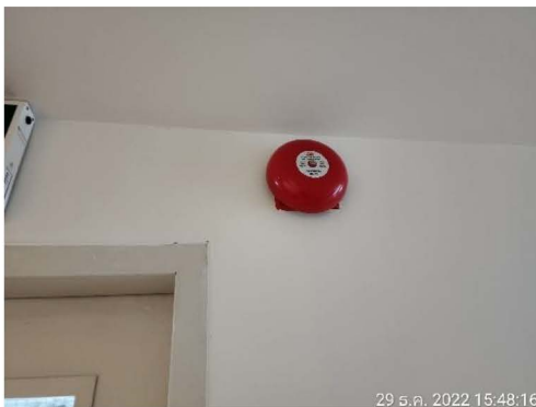
ภาพที่ 2-69 อุปกรณ์ส่งสัญญาณแบบกริ่ง (Alarm Bell)
