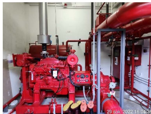
ภาพที่ 2-63 เครื่องสูบน้ำดับเพลิง
