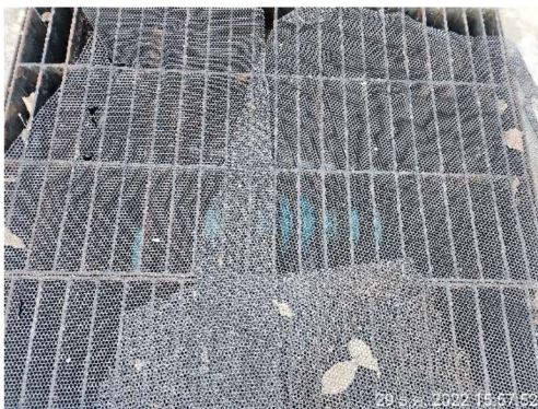
ภาพที่ 2-19 ตะแกรงดักมูลฝอยจากน้ำเสีย
