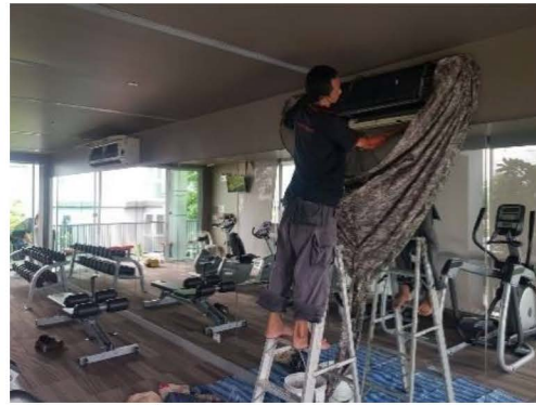
ภาพที่ 2-89 ช่างทำความสะอาด เครื่องปรับอากาศ
