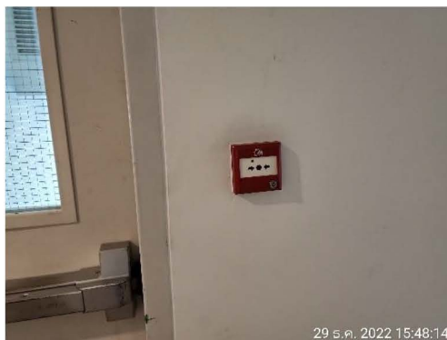
ภาพที่ 2-62 ชุดกดแจ้งเหตุแบบใช้มือ (Manual Station)
