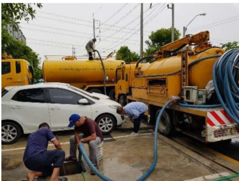
ภาพที่ 2-78 การสูบล้างทำความสะอาดก่อนจากบ่อเกรอะ
