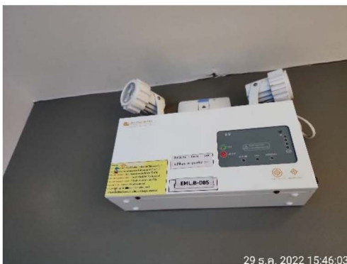
ภาพที่ 2-71 ไฟส่องสว่างฉุกเฉิน
