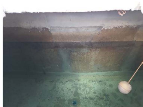
ภาพที่ 2-27 ภายในถังเก็บน้ำเคลือบผิว คอนกรีตป้องกันน้ำซึม
