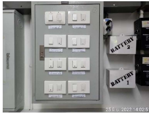
ภาพที่ 2-31 สวิตช์ควบคุมอุปกรณ์ไฟฟ้าแสงสว่างแบบแยกส่วน
