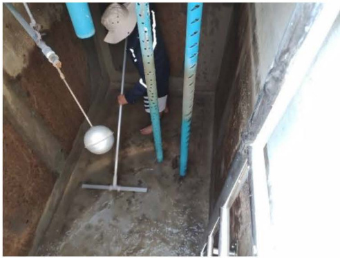
ภาพที่ 3-1 เจ้าหน้าที่ล้างทำความสะอาดถังเก็บน้ำ
