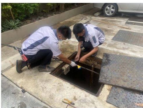
ภาพที่ 2-6 การตรวจสอบระบบบำบัดน้ำเสีย
