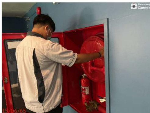
ภาพที่ 2-28 การตรวจสอบระบบป้องกันและระงับอัคคีภัย
