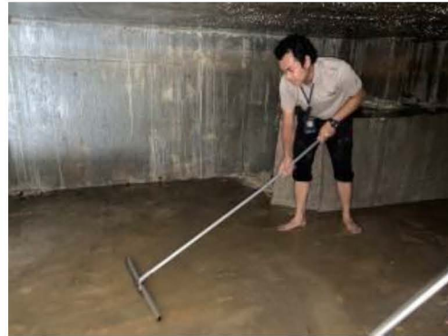
ภาพที่ 2-16 การล้างถังเก็บน้ำ
