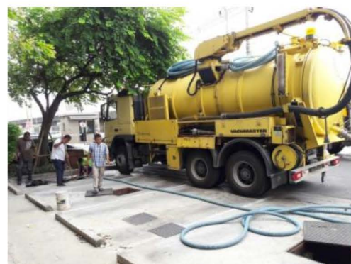
ภาพที่ 2-7 การสูบน้ำก่อนระบบบำบัดน้ำเสีย
