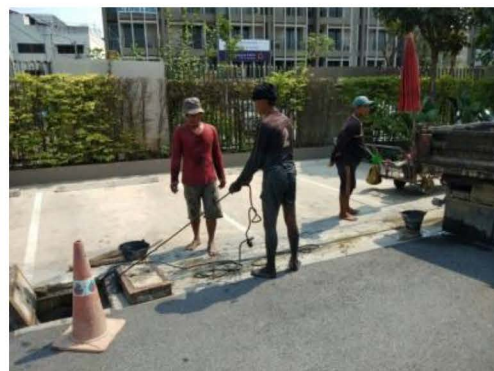
ภาพที่ 2-19 การขุดลอกตะกอนในระบบระบายน้ำ
