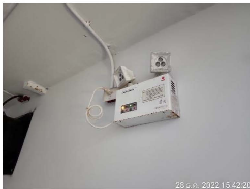
ภาพที่ 2-27 ไฟส่องสว่างฉุกเฉิน (Emergency Light)
