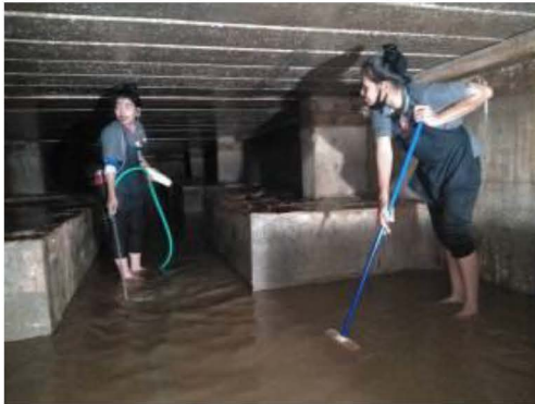
ภาพที่ 2-16 การล้างถังเก็บน้ำ
