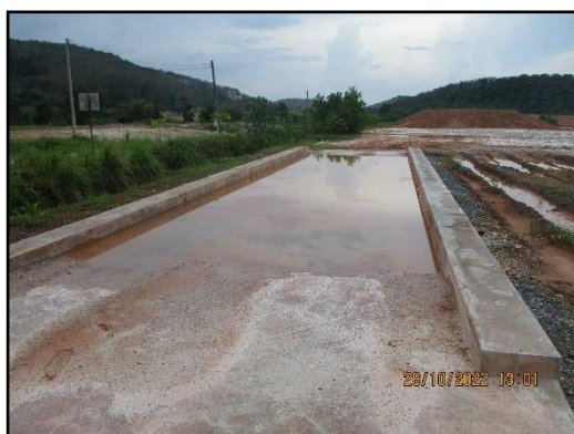
ภาพที่ 3.50 บ่อล้างล้อรถบรรทุก และฉีดทำความสะอาดถนน
