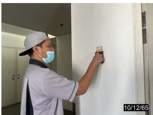
ตรวจสอบ Fire Alarm Manual Station
