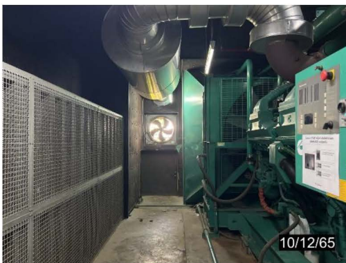
ภาพที่ 2-10 พัดลมระบายอากาศภายในโครงการ
