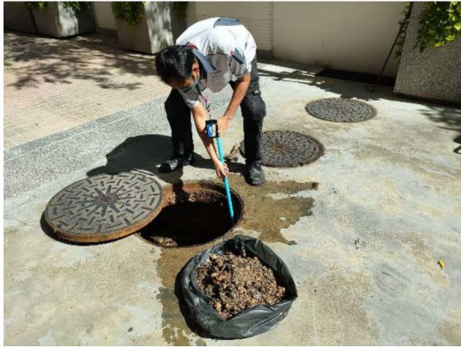
ภาพที่ 2-23 ช่างอาคารตรวจสอบบ่อดักไขมัน และทำความสะอาด
