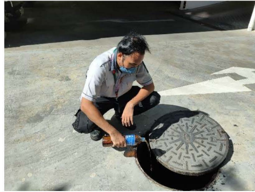
ภาพที่ 2-23 ช่างอาคารตรวจสอบบ่อดักไขมัน และทำความสะอาด
