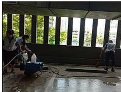
ภาพที่ 3-2 ตรวจสอบและขุดลอกรางระบายน้ำ
