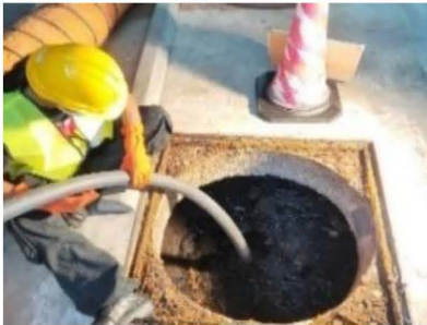
ภาพที่ 2-29 การสูบล้างและดูดตะกอนบ่อบำบัดน้ำเสีย อาคาร A และ B
