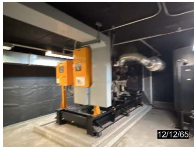
ภาพที่ 2-14 เครื่องกำเนิดไฟฟ้าสำรองอาคาร Tower A และ Tower B
