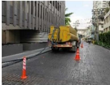
ภาพที่ 2-29 การสูบล้างและดูดตะกอนบ่อบำบัดน้ำเสีย อาคาร A และ B
