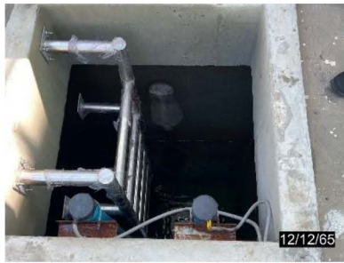
ภาพที่ 2-12 ถังเก็บน้ำประปาชั้นใต้ดิน และชั้นหลังคา
