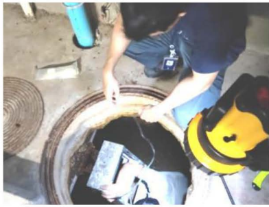
ภาพที่ 3-1 ตรวจสอบการทำงานปั้มน้ำและซ่อมแซมท่อน้ำ
