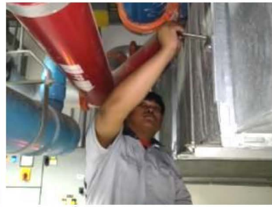
ภาพที่ 3-1 ตรวจสอบการทำงานปั้มน้ำและซ่อมแซมท่อน้ำ
