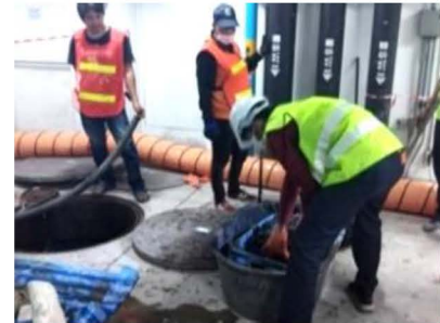
ภาพที่ 2-29 การสูบล้างและดูดตะกอนบ่อบำบัดน้ำเสีย อาคาร A และ B
