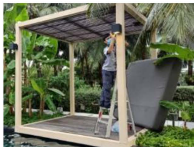
ภาพที่ 3-3 ซ่อมแซมระบบไฟฟ้าส่องสว่าง
