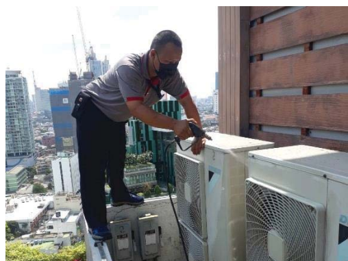
ล้างทำความสะอาดระบบปรับอากาศพื้นที่ส่วนกลาง
