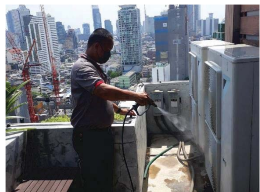
ล้างทำความสะอาดระบบปรับอากาศพื้นที่ส่วนกลาง
