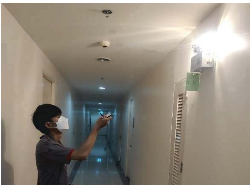
ตรวจเช็คระบบป้องกัน และแจ้งเหตุเพลิงไหม้
