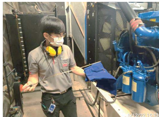
ทดสอบเครื่องยนต์กำเนิดไฟฟ้าสำรองประจำสัปดาห์
