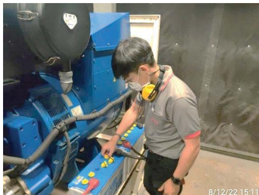
ทดสอบเครื่องยนต์กำเนิดไฟฟ้าสำรองประจำสัปดาห์
