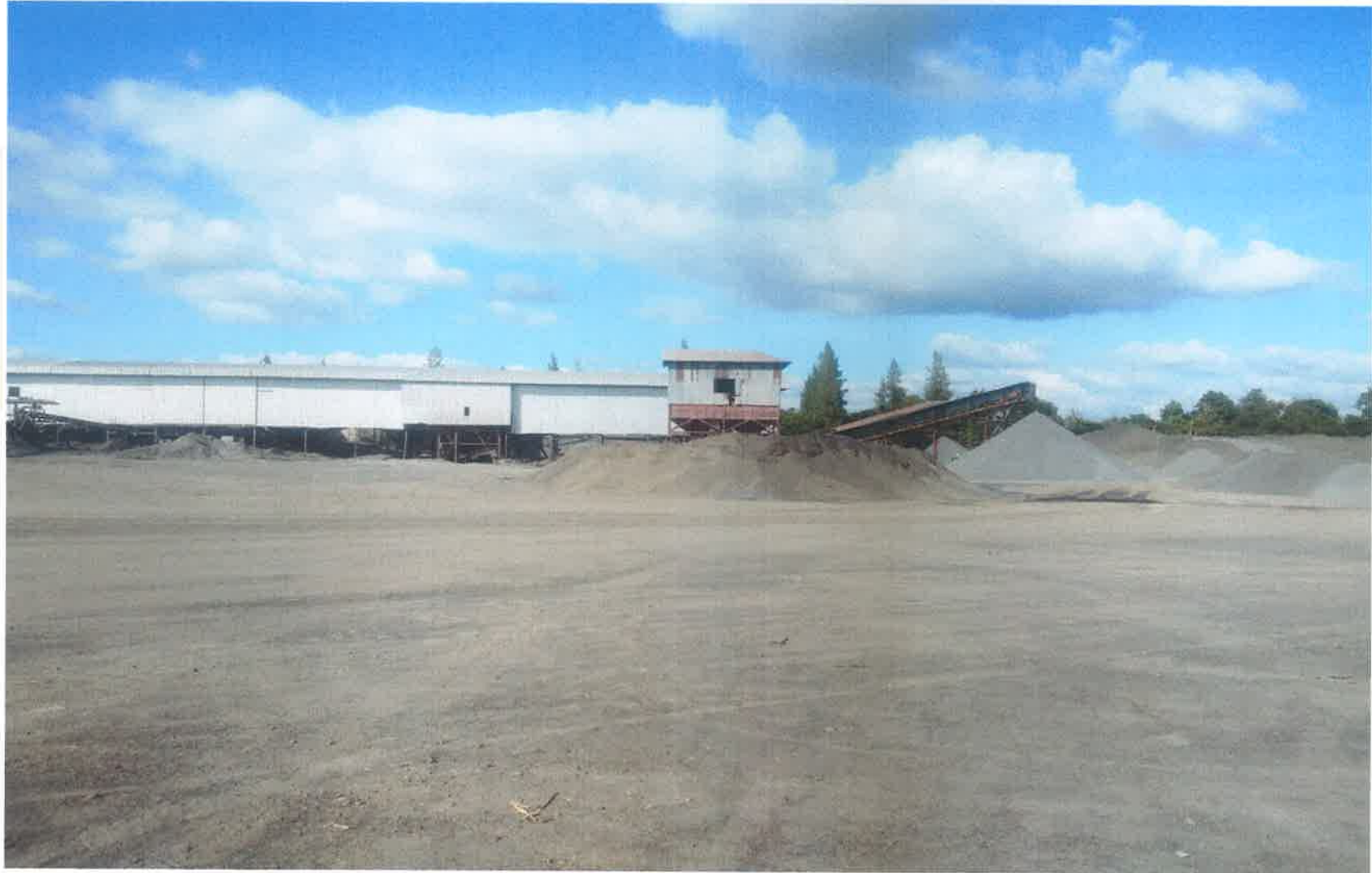
( รูปที่ 7.1 ) อาคารโรงโม่ใช้เมทัลชีทปิดคลุมอาคาร โรงโม่ที่1
